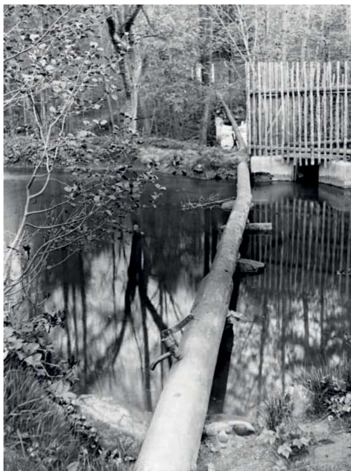
Dřevěné potrubí na Trotince s výtokovým ventilem
