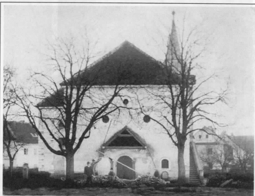
Průčelí kostela před položením základního kamene přestavby, asi 18. listopad 1898 (archiv muzea v Miletíně)
