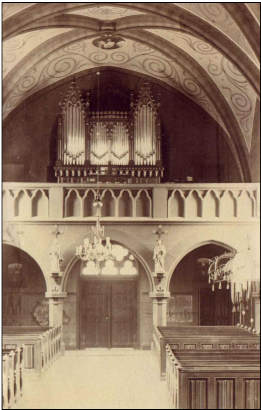
Interiér kostela po rekonstrukci, kruchta
