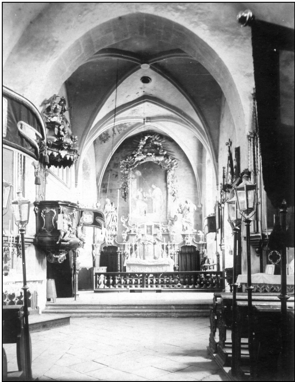
Presbytář kostela v roce 1892
